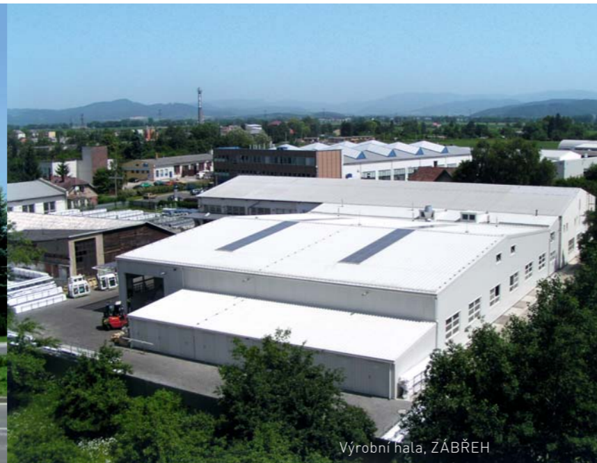
Administrativní budova, ZÁBŘEH
